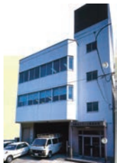
1977年旧本社ビル
