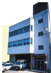
1977 年 旧本社ビル
